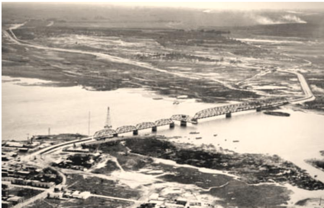
(Izq.) pueblo; (Der.) Arenales, columnas/aerocarril, Puente/embarcadero, 1940. (Google)
